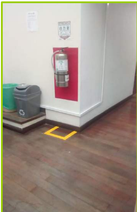
INSTALACIÓN Y DEMARCACIÓN EXTINTORES
