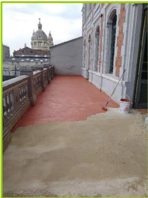
IMPERMEABILIZACIÓN TERRAZAS
