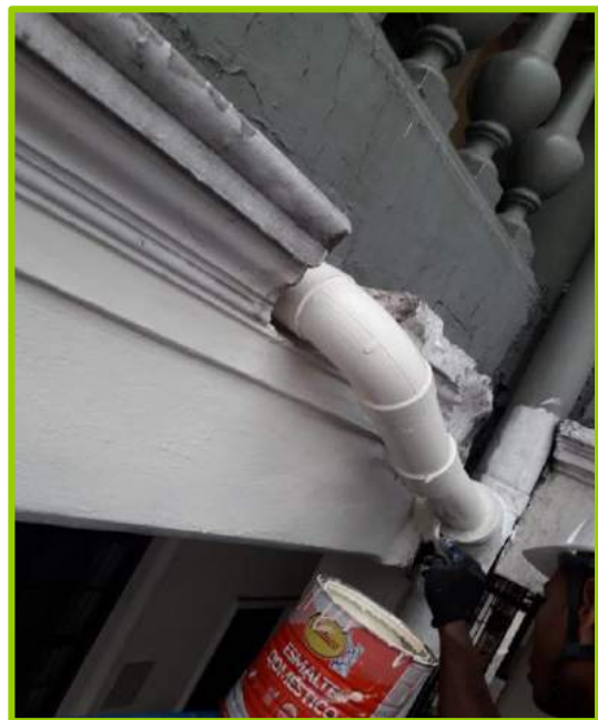
INSTALACIÓN TUBERIA ACCESORIOS DE BAJANTES
