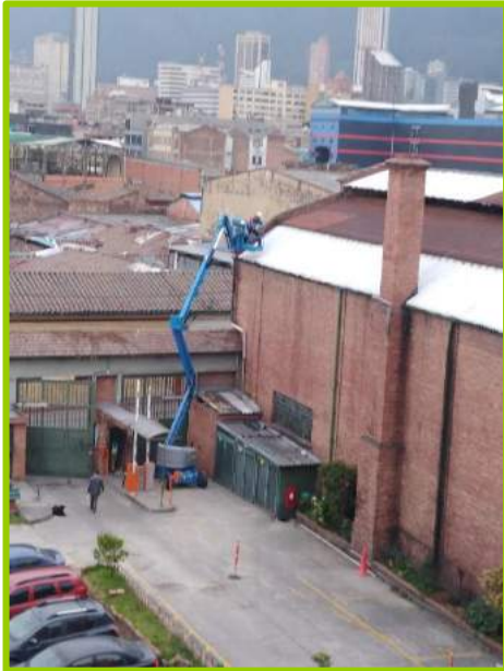
CANALES Y BAJANTES TALLERES PATIO NORTE
